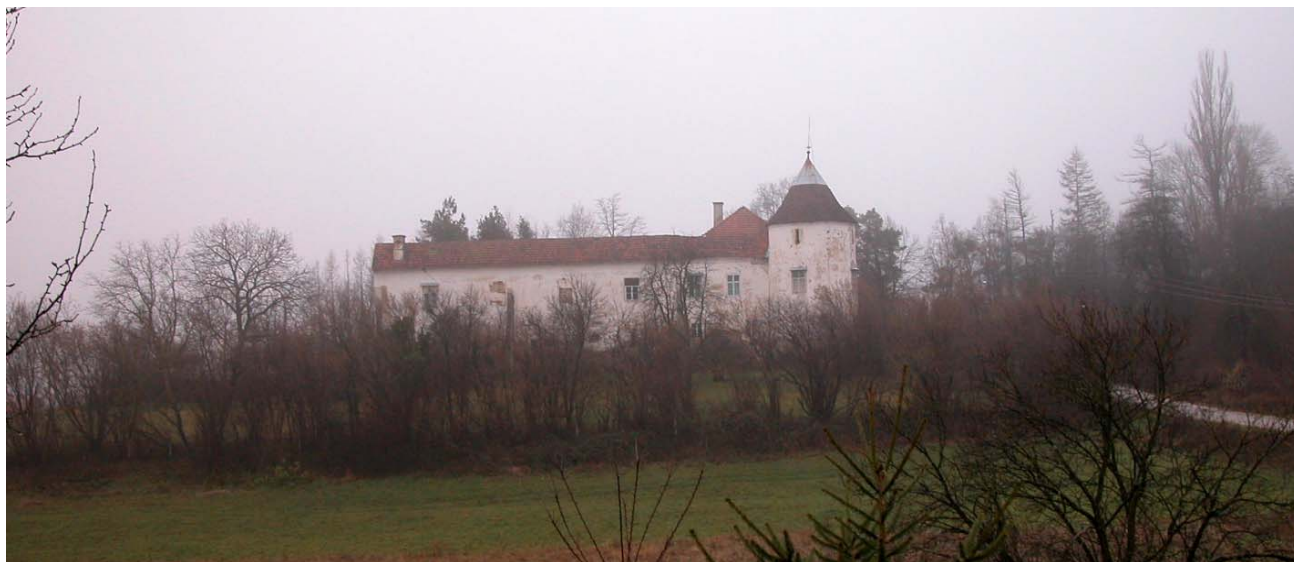
dvorac Gorica, istočno pročelje
